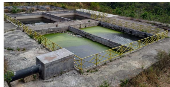
Gambar 10. Kondisi air lindi pada kolam penampungan dengan warna hitam pekat dan agak kehijauan di permukaannya
