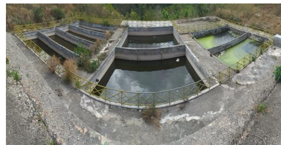
Gambar 11. Kondisi kolam stabilisasi dan kolam pengolahan air lindi yang berada di sebelah kolam penampungan
