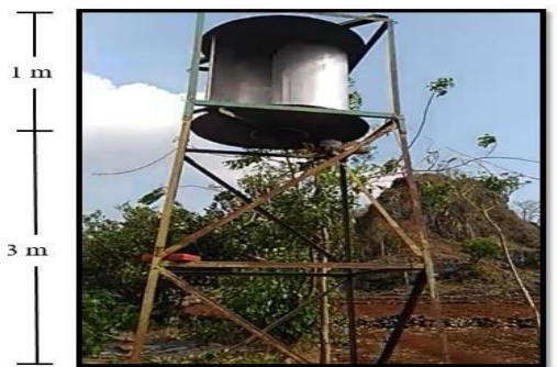
Gambar 3. Turbin Angin Savonius Dengan Tipe U
