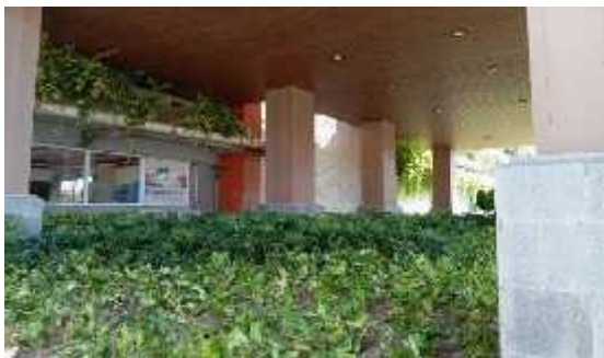
Gambar 2. Vegetasi pada Gedung MLCP
