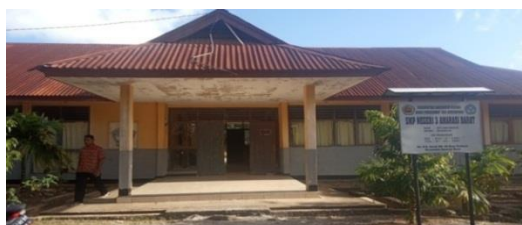
Gambar 1. Tampak Depan Gedung SMP Negeri 3 Amarasi Barat
