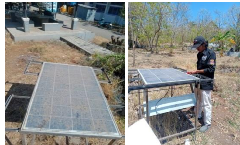
Gambar 4 Pengukuran tegangan dan arus
