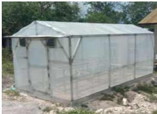
Gambar 2. Hasil rancang bangun rumah pengering kopi menggunakan plastik ultra violet.
