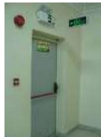
Gambar 10. Bentuk Pintu Darurat di Dalam Gedung
