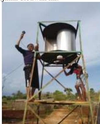
Gambar 2. Instalasi turbin angin savonius.
