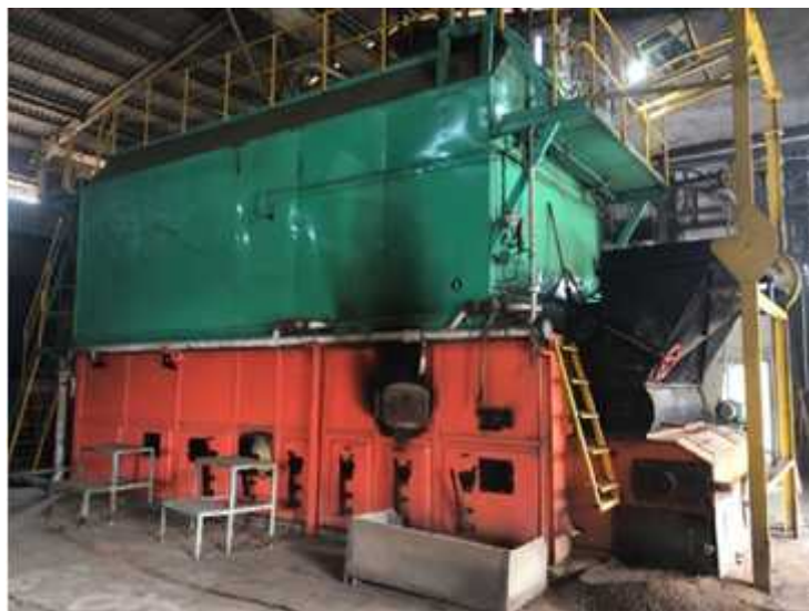
Gambar 2. Ketel Uap Pipa Air Tipe Szl 10000
