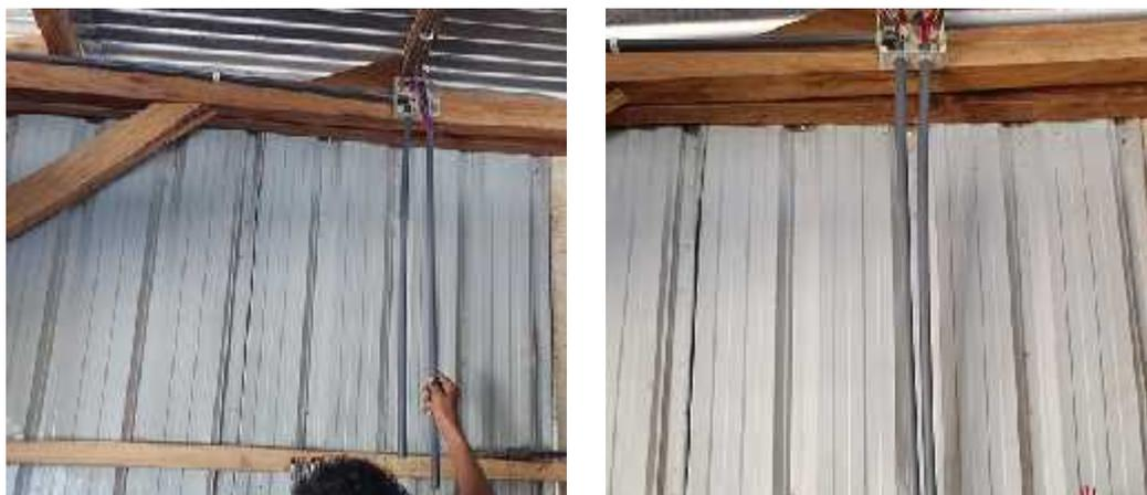
Gambar 2. Pemasangan Pipa *Conduit*
