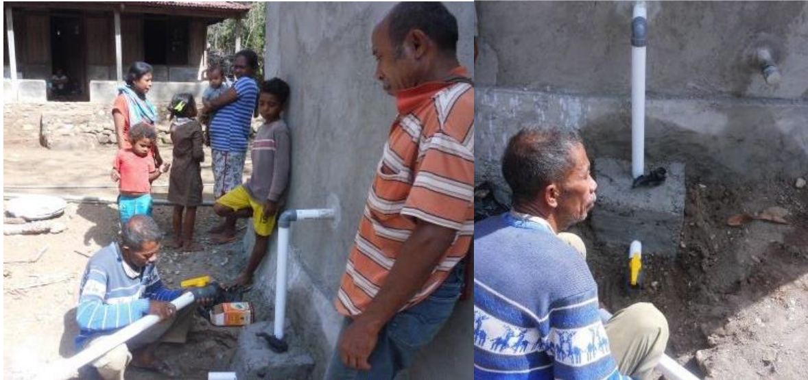
Gambar 11. Pemasangan kran dan pipa distribusi di Bak Penampung
