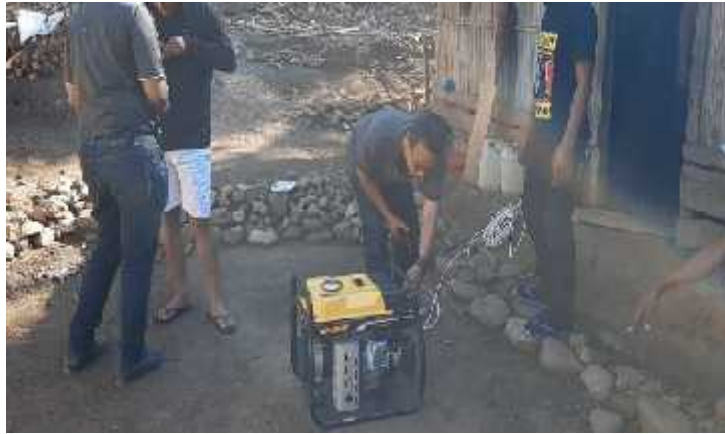
Gambar 9. Pemasangan dan Pengujian Genset Bensin
