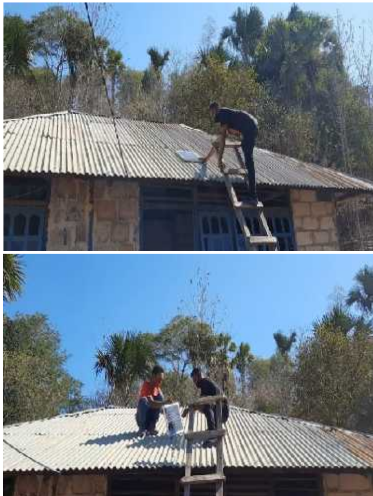
Gambar 7. Pemasangan Panel Surya
