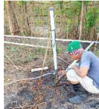
Gambar (c) Pemasangan Kran
