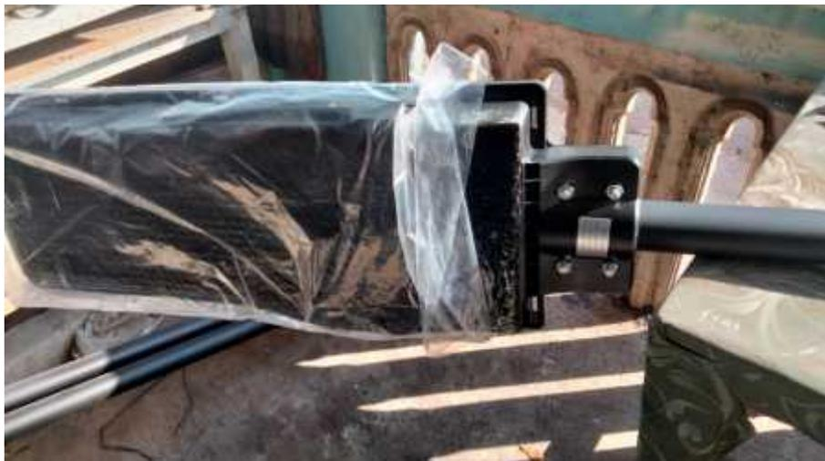
Gambar 3. Penyesuaian Ukuran Lebar Tiang dengan Lampu PJU Sebelum Dilakukan Pengelasan
