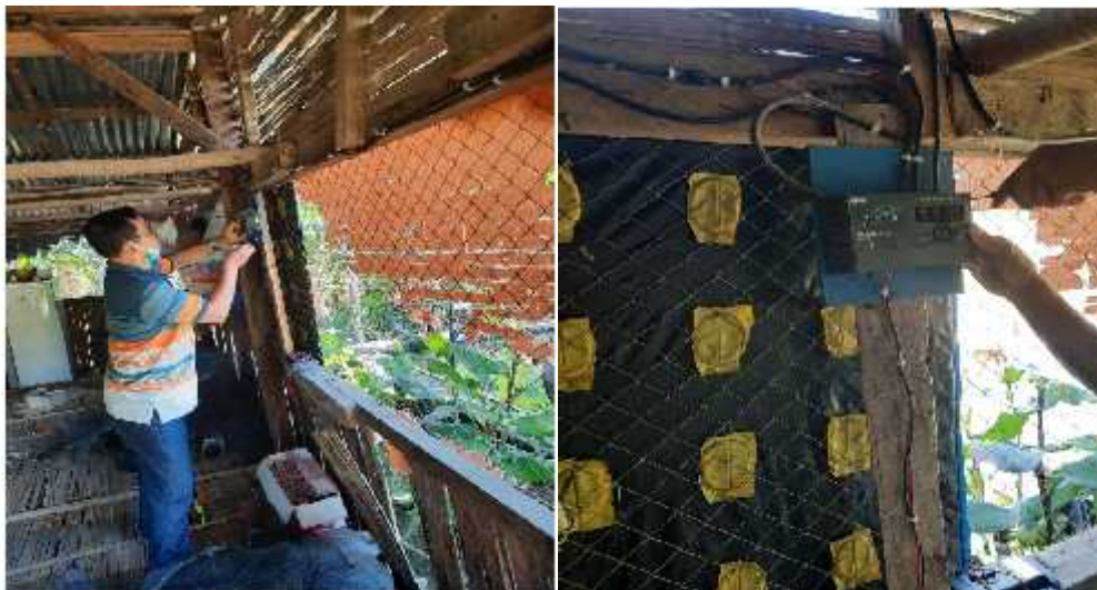
Gambar 5. Penggantian Panel Kontrol Solar Sel
