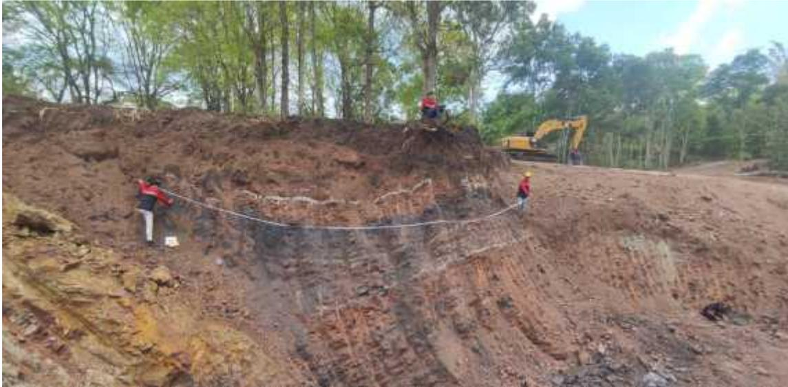
Gambar 1. Lokasi Penggalan Lapisan Batuan yang Mengandung Mangan (lapisan hitam)
