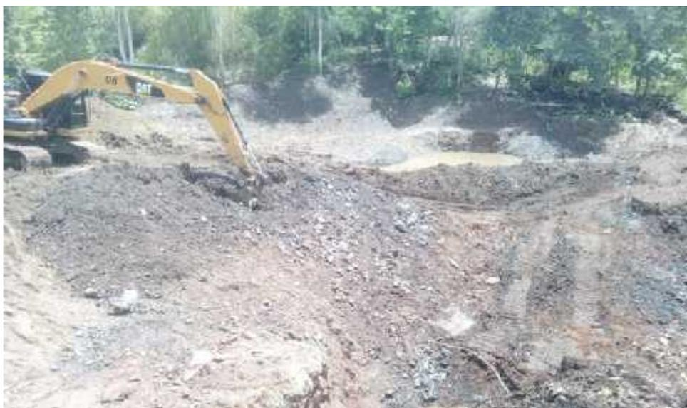
Gambar 2. Penggalan Lapisan yang Mengandung Mangan Setelah Tanah Penutup dikupas
