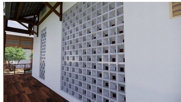
Gambar 11. Roster pada dinding bangunan
