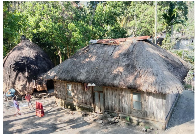
Gambar 4. Bangunan ume noe (kanan) dan ume hana (kiri)
