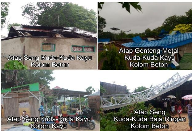
**Gambar 7.** Kondisi bangunan terkena angin puting beliung di lereng
