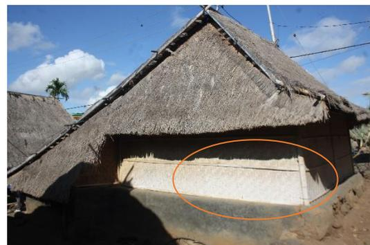
**Gambar 8.** Anyaman Bambu untuk Keluar Masuknya Udara
