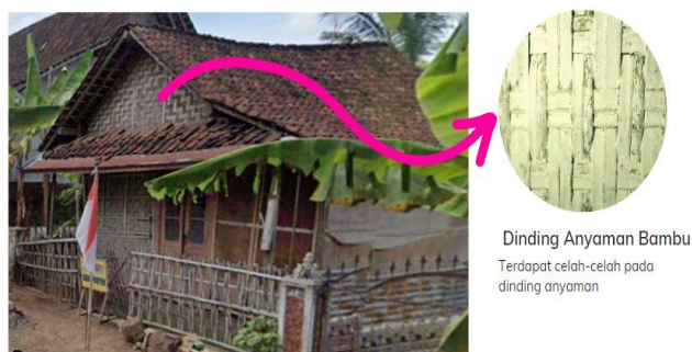
Gambar 6. Dinding Berpori pada Anyaman Bambu
