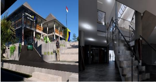
Gambar 3. Penerapan Hubungan Langsung Arsitektur Neo Vernakular pada Eksterior dan Interior Kantor Dinas PUPR
