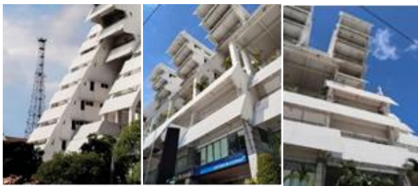
Gambar 13. Tampilan Fasad bangunan Intiland Tower Surabaya
