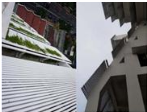
Gambar 14. Tampilan Aluminium Spandril pada Fasad. Sumber: www.ciputra.ac.id (2020)
