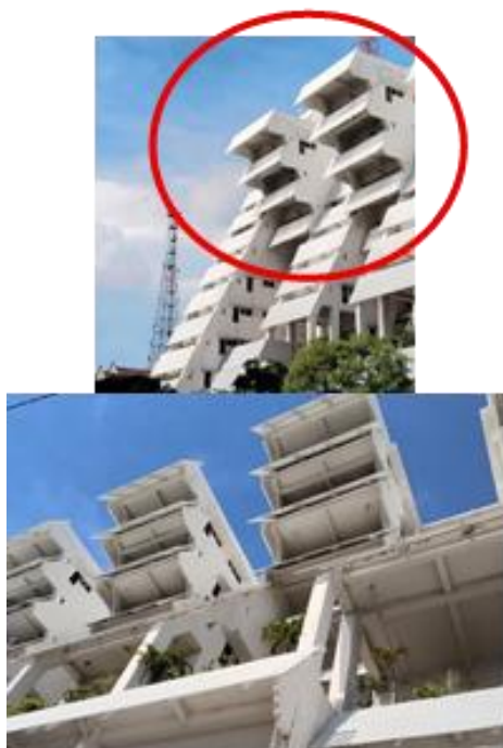
Gambar 18. Shading atau overhang Intiland Tower Surabaya
