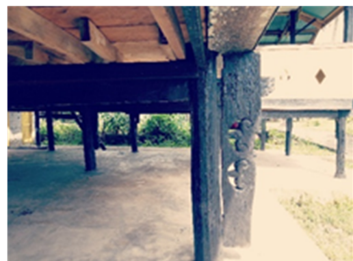
Gambar 7. Konstruksi pondasi dan gelagar pada Rumah Godang Suku Patopang
