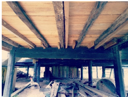
Gambar 10. Konstruksi pondasi dan gelagar pada Rumah Godang Suku Piliang
