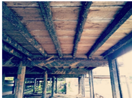
Gambar 6. Konstruksi pondasi dan gelagar pada Rumah Godang Suku Melayu
