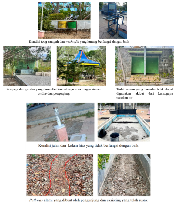
Gambar 14. Kondisi fasilitas dan prasarana pendukung di lokasi pengamatan ke-3
