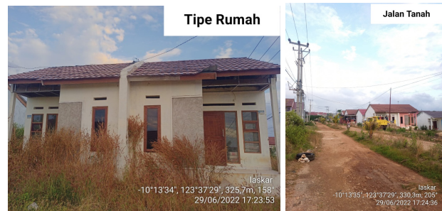
Gambar 3. Kondisi Perumahan Graha Sentosa. Sumber: Dokumentasi, 2022
