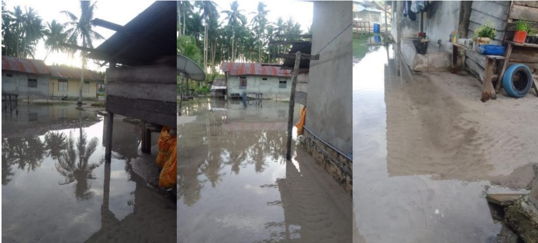
Gambar 4. Pemukiman penduduk di pesisir Desa Warbal banjir akibat air laut pasang karena kurang optimalnya talud yang ada
