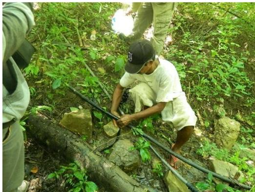
Gambar 1 Jaringan Pipa Distribusi yang Bocor
