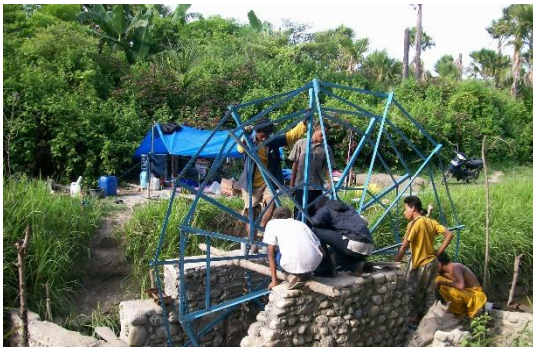
Gambar 5. Pemasangan kincir air
