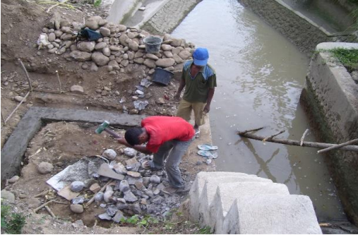
Gambar 4. Persiapan pemasangan Pondasi kincir air
