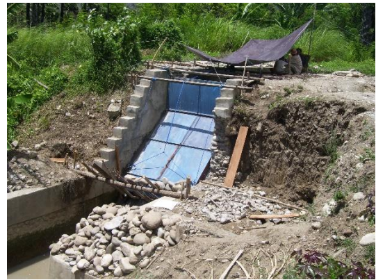
Gambar 10. Tale race turbin yangtelah terpasang
