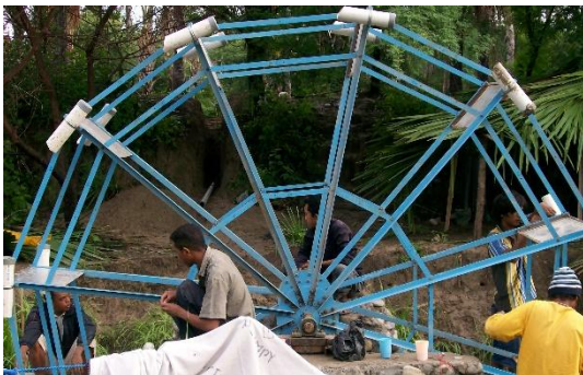
Gambar 6. Kincir air yang telah terpasang
