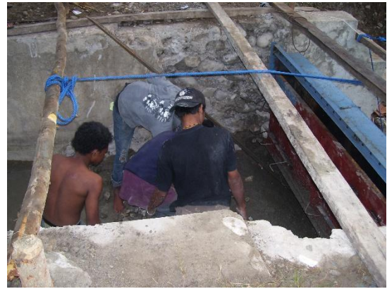
Gambar 9. Pemasangan pondasi turbin
