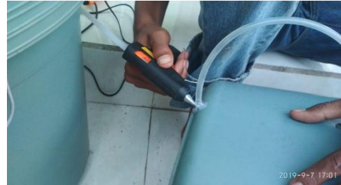
Gambar 10 Pengeleman Slang
