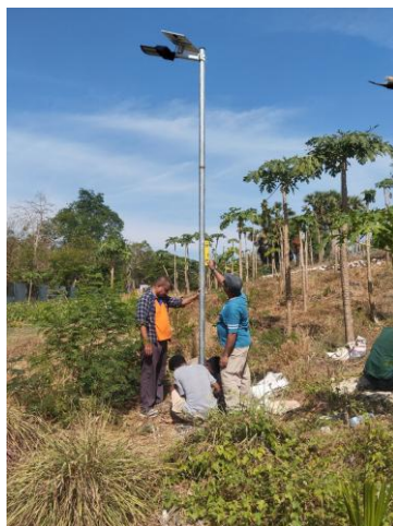
Gambar 8 Pemasangan lampu panel surya
