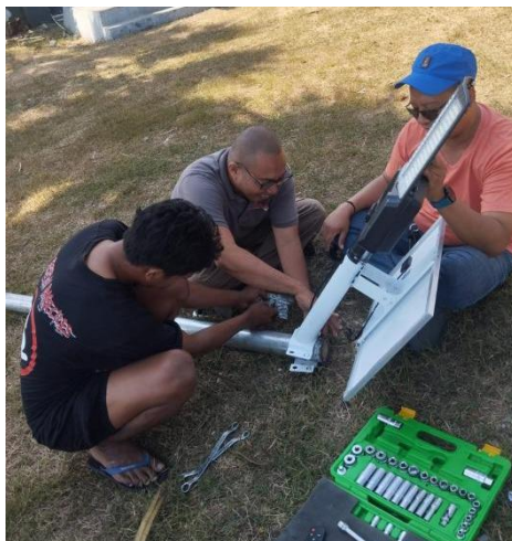
Gambar 7 Perakitan lampu panel surya
