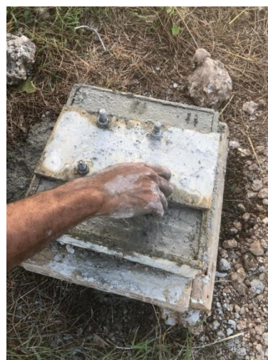
Gambar 6 Penyiapan dudukan tiang penyangga
