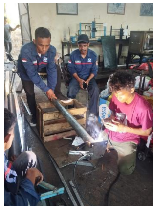
Gambar 5 Penyiapan tiang penyangga
