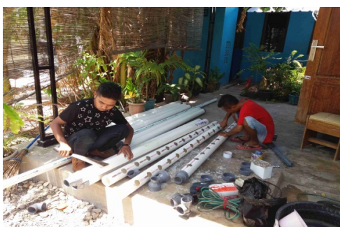
Sumber : Laporan akhir kegiatan I b M Gambar.8 P Pipa PVC yang telah dilubangi
