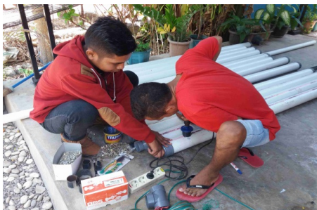
Sumber : Laporan akhir kegiatan I b M Gambar.7 Proses Melubangi Pipa PVC
