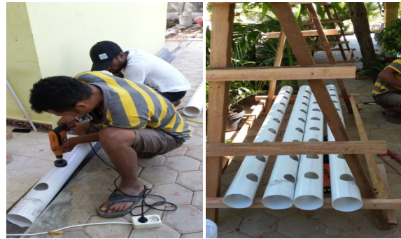
Gambar 1. Proses Perakitan Instalasi Hidroponik
