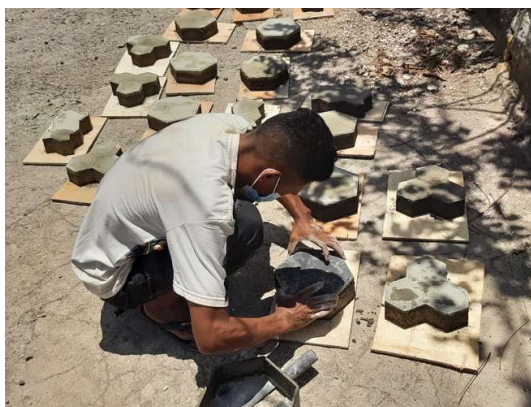
Gambar 3. Proses pelepasan paving block dari cetakan
