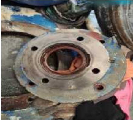
Gambar 1. Pembongkaran Gearbox Agitator
