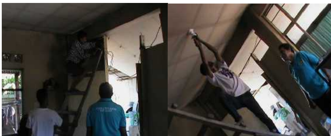
Gambar 2. Gambar sebelah kiri mahasiswa diawasi para Dosen memasang instalasi Listrik Tenaga dan Gambar sebelah kanan mahasiswa yang dibantu para Dosen memasang Instalasi Listrik Penerangan.
