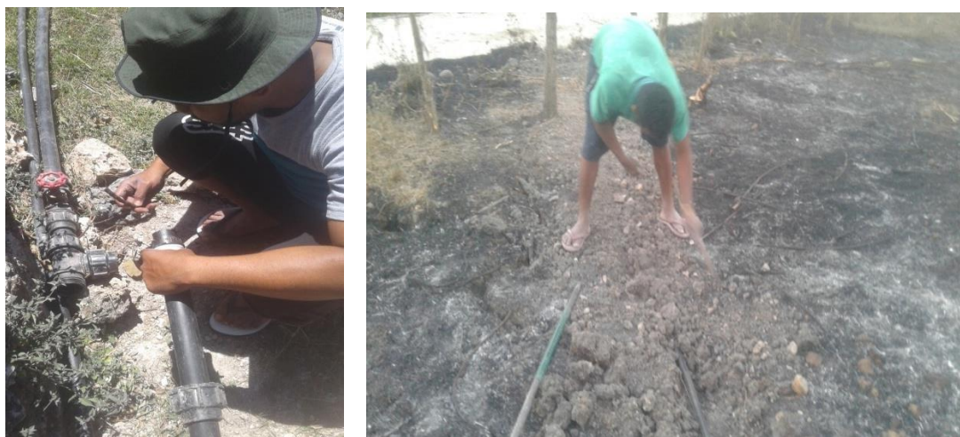
Gambar 7. Pekerjaan instalasi jaringan air bersih
