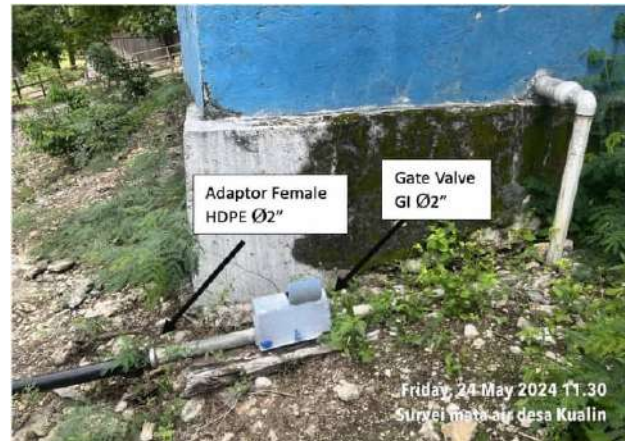
Gambar 4. Hasil Survei Instalasi Pipa dari Reservoir Utama
