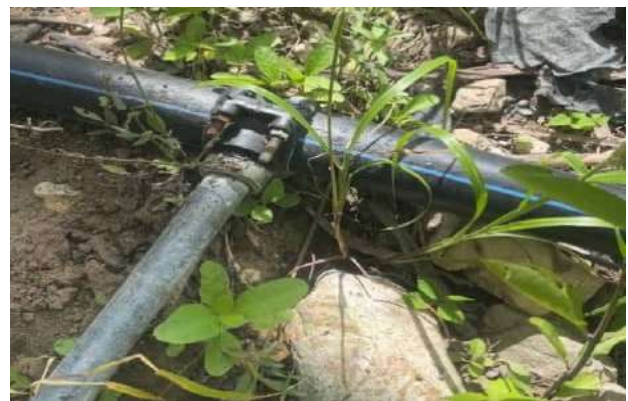
Gambar 6. Instalasi Pipa Air yang Menyebabkan Tekanan Hidrostatik Berkurang
