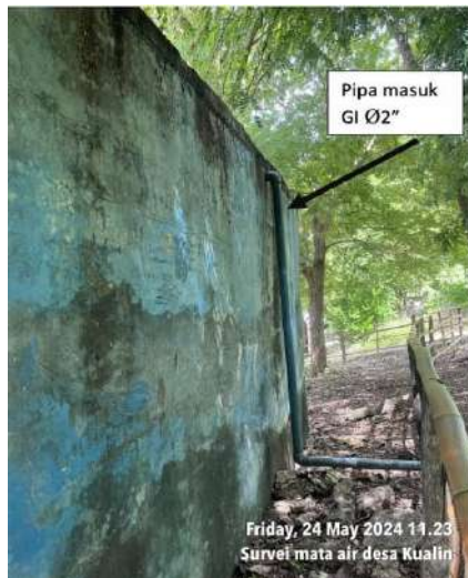
Gambar 2. Reservoir menerima air dari mata air secara gravitasi menggunakan pipa berukuran 2"
