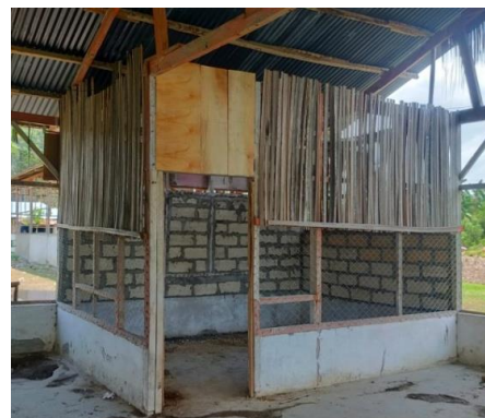
Gambar 1. Pembangunan kandang ayam
