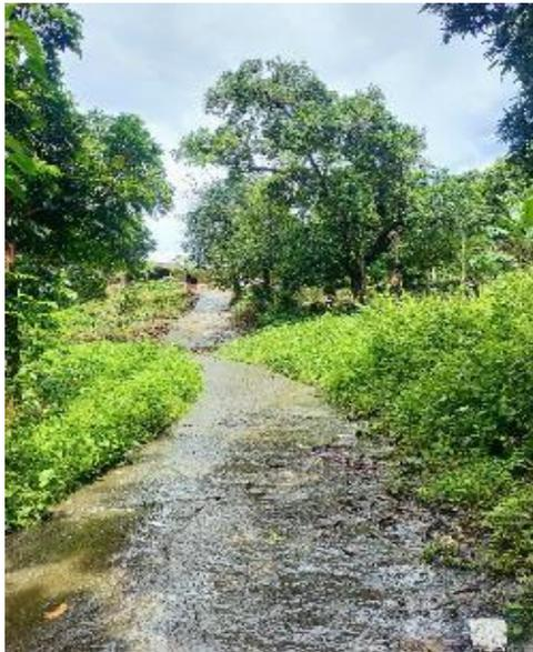
Gambar 1. Kondisi Jalan Eksisting dengan Rabat Beton
