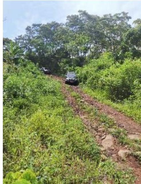
Gambar 3. Kondisi Jalan Eksisting dengan Permukaan Tanah
